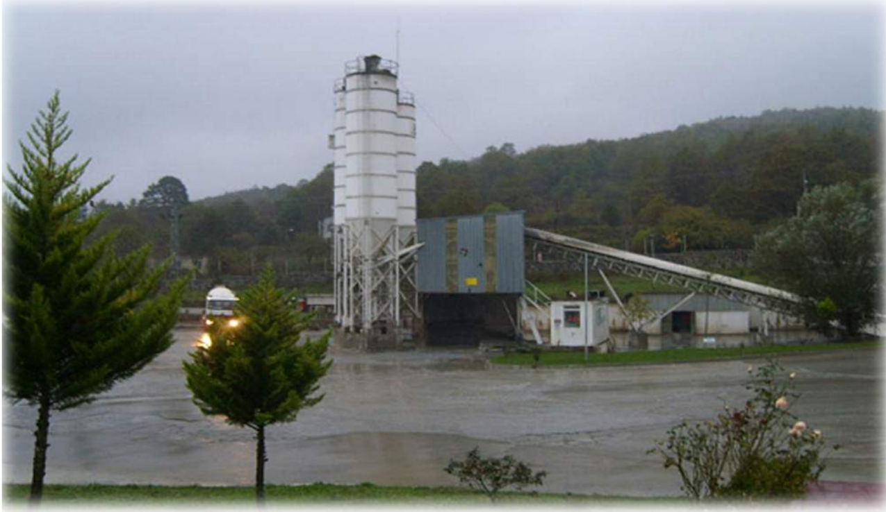
ŞİLE BETON SANTRALİ TESİSİ ŞİLE/İSTANBUL
