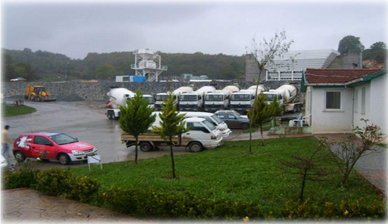
ŞİLE BETON SANTRALİ TESİSİ ŞİLE/İSTANBUL
